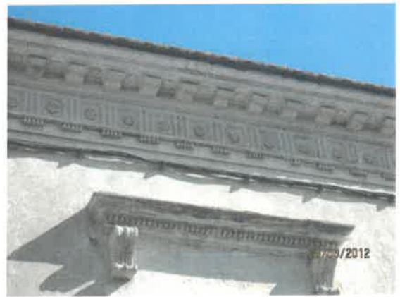
Corniche complexe immeuble « sophistiqué »
